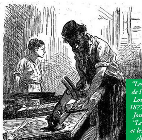
Fig. 244. — Débitage du bois à la main pour la fabrication des allumettes.
