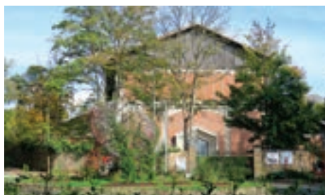
Arrière Hangar Y, face Sud, octobre 2022
