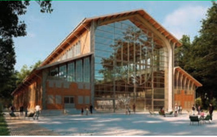
Hangar Y, face Nord, la verrière, octobre 2022
